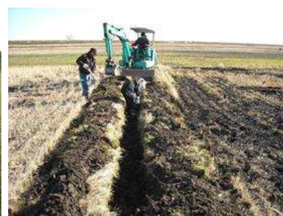
(水路の泥上げ)
